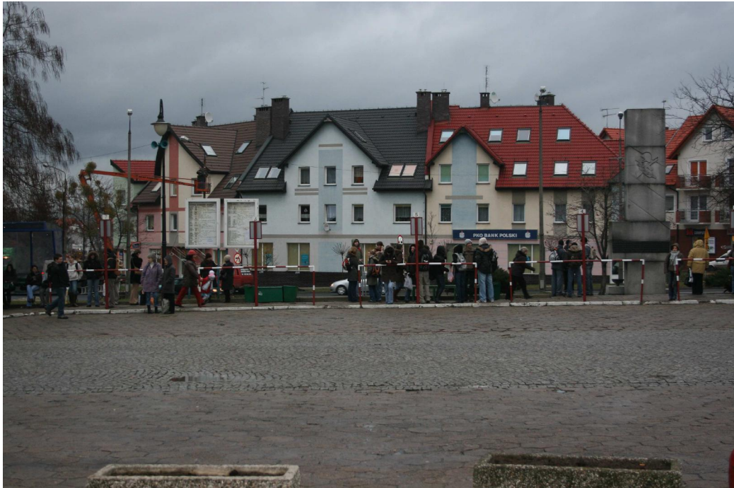
Fot. 6. Plac Piłsudskiego. Widoczna zniszczona nawierzchnia płyty dworca.
