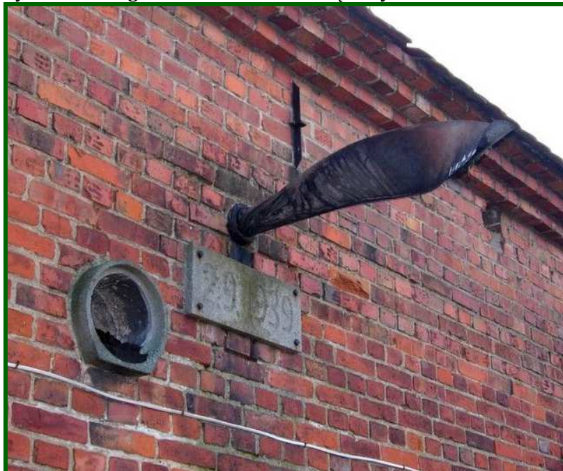
Rysunek 8 Śmigło wmurowane w ścianę budynku
