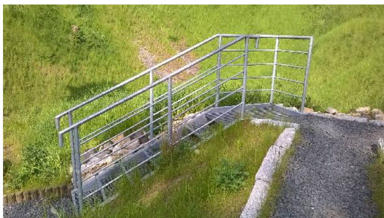
schody w konstrukcji stalowej - Geopark krajowy Góra Św. Anny, fot: P. Marek
