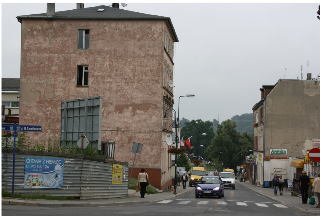
Fot. 6. ul. I. Daszyńskiego w Trzebnicy.
