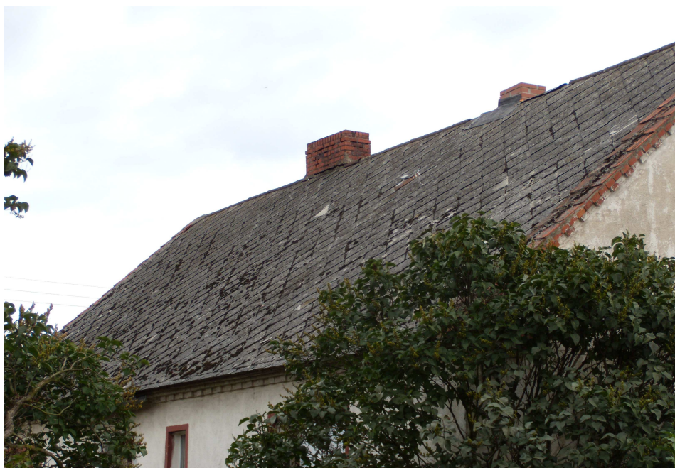
Fot. 4. Pomalowane płyty eternitowe na budynku mieszkalnym w Kobylicach.
