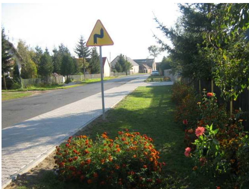
Rysunek 6 Wyremontowana droga powiatowa wraz z chodnikiem przebiegająca wzdłuż miejscowości
