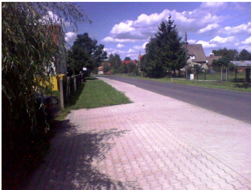
Rysunek 5 Wyremontowana droga powiatowa wraz z chodnikiem przebiegająca wzdłuż miejscowości
