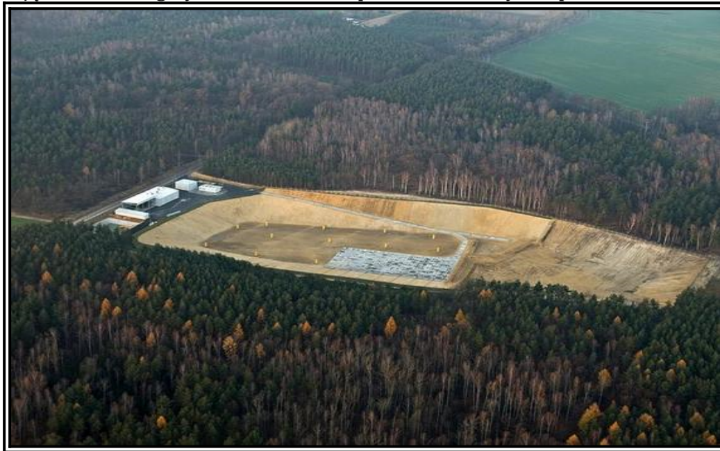
Zdjęcie 9 Widok z góry na składowisko odpadów komunalnych w pobliżu Marcionowa
